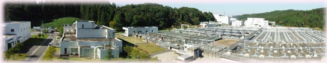
平成28年10月現在 管理棟屋上よりSP棟から水処理施設をパノラマ撮影
