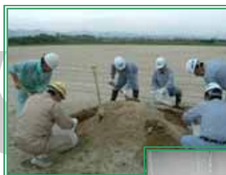
左：土嚢積訓練 (県北浄化センター)
