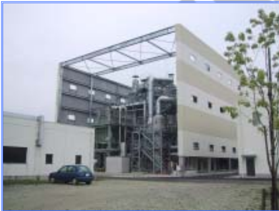
稼動した汚泥溶融施設全景
