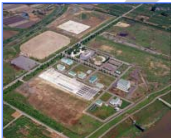
県北浄化センター全景
