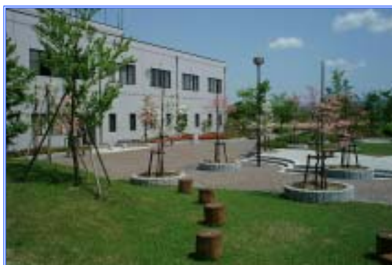
県北浄化センター中庭
