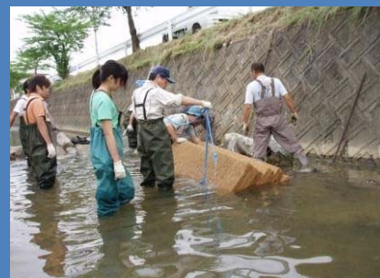
水草の基盤材（ヤマト）設置
