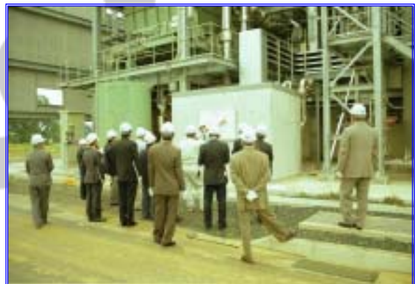
汚泥溶融施設見学風景
