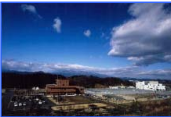
県中浄化センター全景
