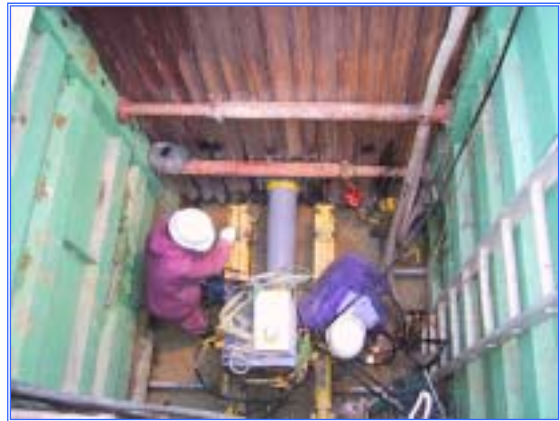
管渠推進工事現場(低対荷力方式)
